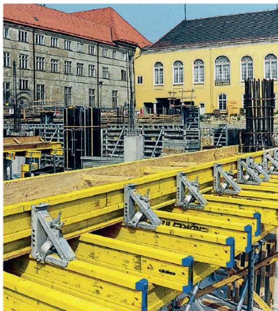
Fôrma fácil de vigas de borda com uso de gravata de viga 20.
